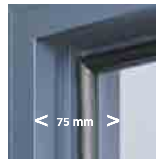
Occultation renforcée et performances thermiques améliorées grâce à la présence d'une feuillure et de son joint d'étanchéité
